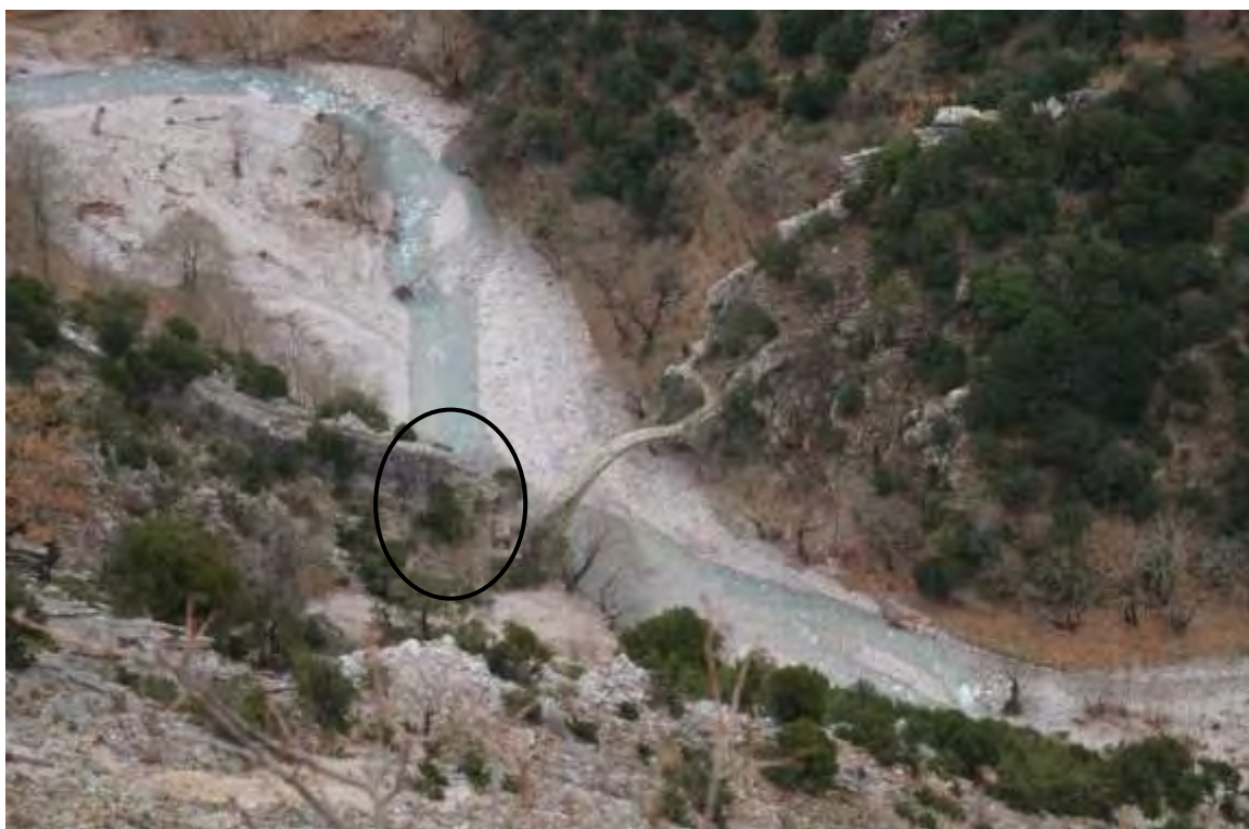
Σημερινή κατάσταση: βραχώδης μάζα που σχεδόν αιωρείται πάνω από το ένα άκρο του γεφυριού
