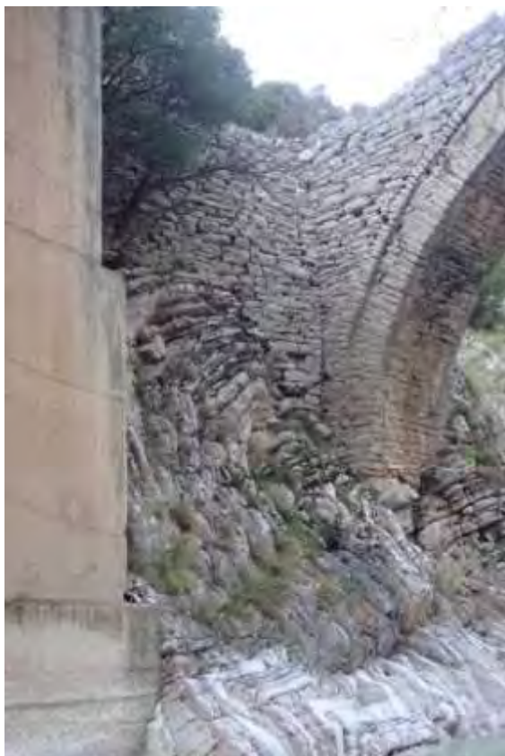
Βλάβηση κοντά στο «απέναντι» βάθρο
