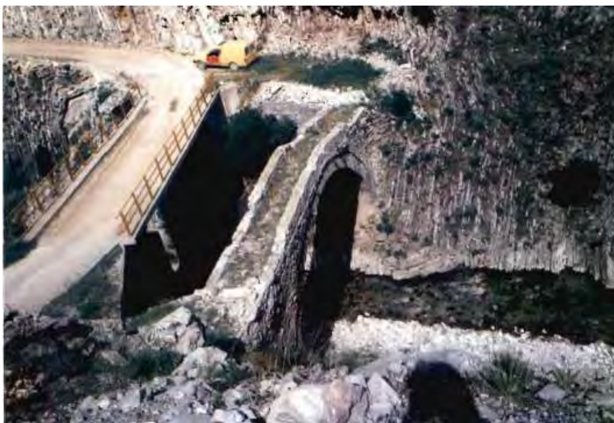
Άνωθεν άποψη της βυζαντινής γέφυρας Δροσάτου και της σύγχρονης γέφυρας από Ο.Σ. προ 1995 διακρίνονται τα στηθαία [1]
