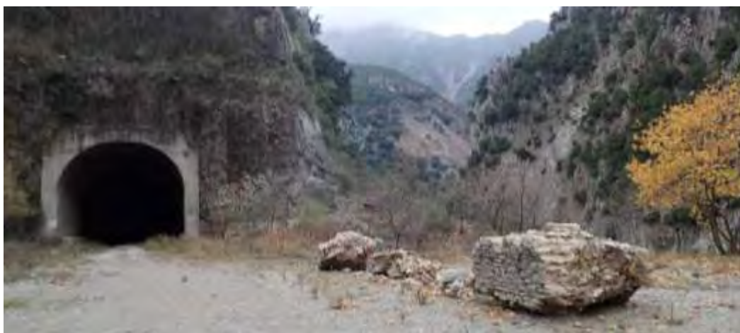
Τμήματα της λιθοδομής της γέφυρας Κοράκου που διασώθηκαν
