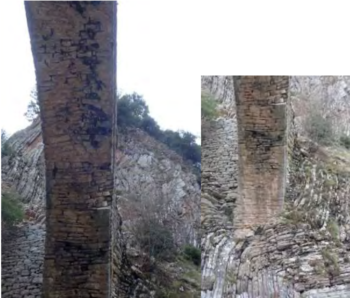
Παρειά που πρόσκειται στη νέα γέφυρα: ρηγματώσεις και μικρο-μετακινήσεις λίθινων στοιχείων
