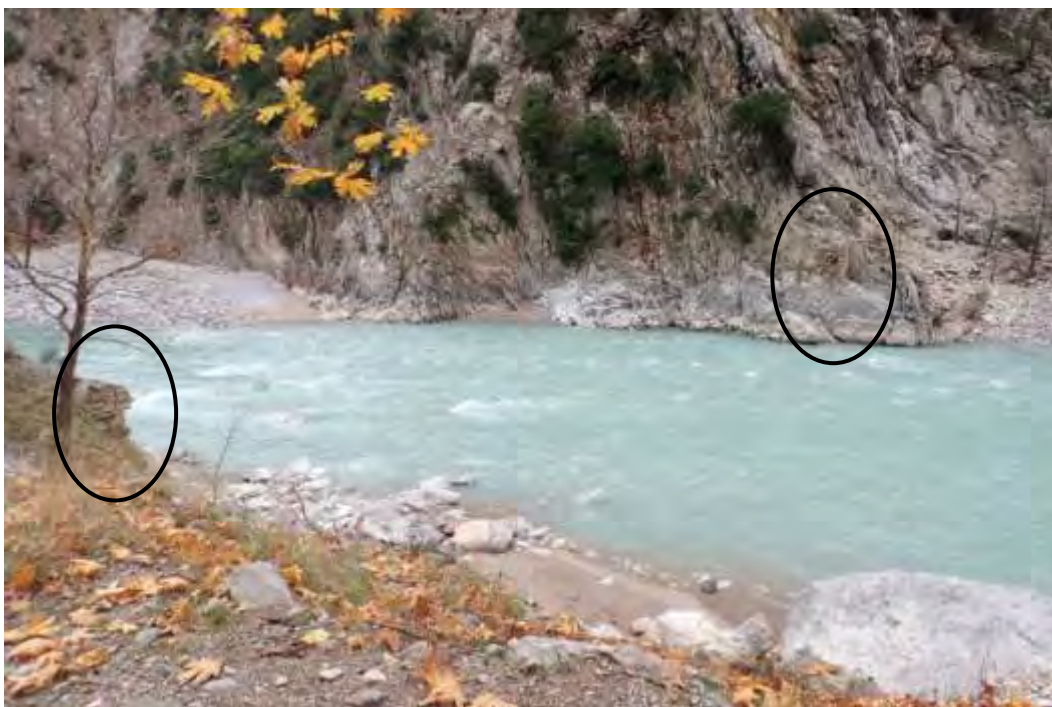
Διακρίνεται η γένεση του τόξου της γέφυρας στις δυο όχθες
