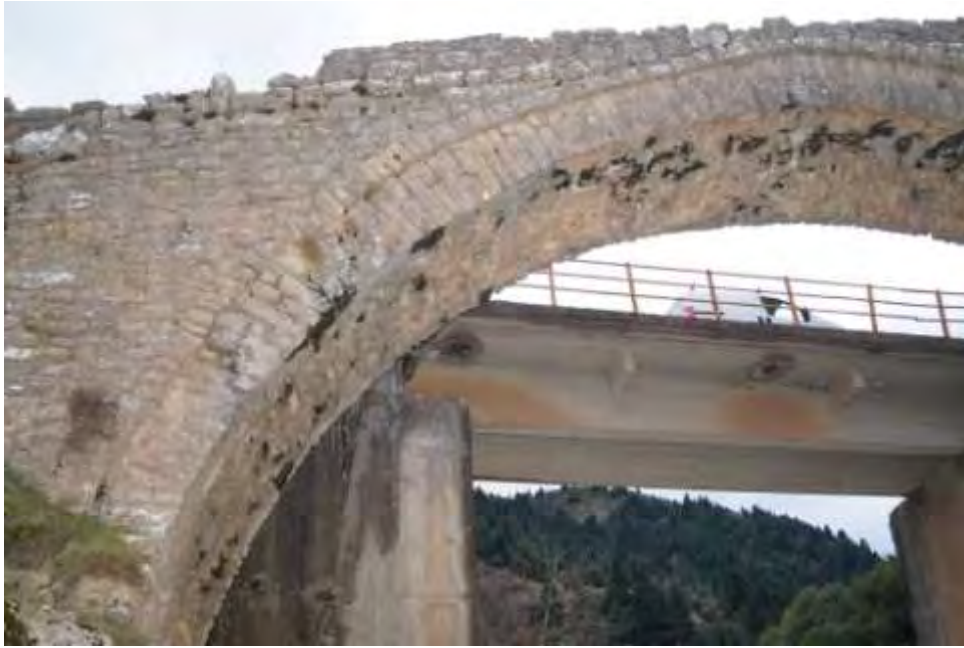
Παρειά που πρόσκειται στη νέα γέφυρα: ρηγματώσεις και μικρο-μετακινήσεις λίθινων στοιχείων
