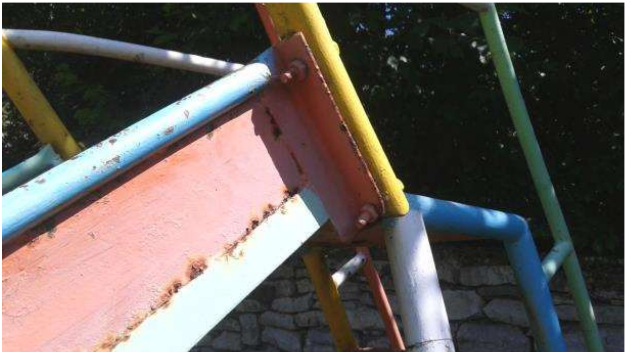
Εικόνα 17: Ακάλυπτες βίδες στην τσουλήθρα.
