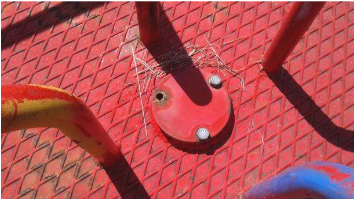
Εικόνα 13: Ελλιπής στήριξη του άξονα του μύλου Νο1.
