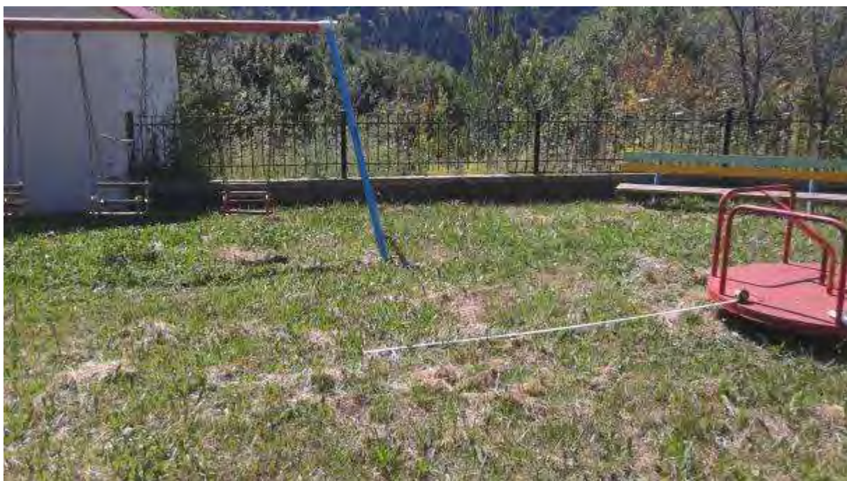
Εικόνα 15: Επικάλυψη των χώρων πτώσης της κούνιας Νο2 και του μύλου Νο1.
