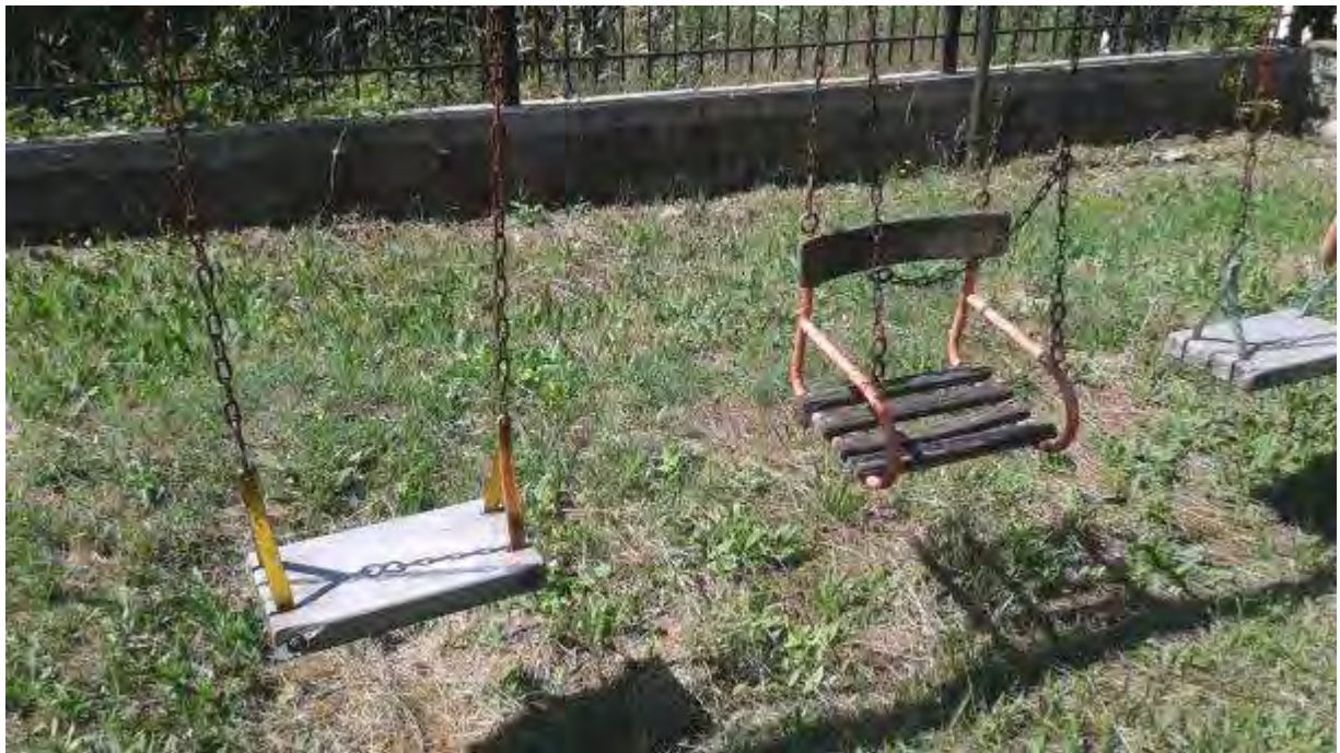
Εικόνα 9: Ακατάλληλα καθίσματα και αλυσίδες στην κούνια Νο1.
