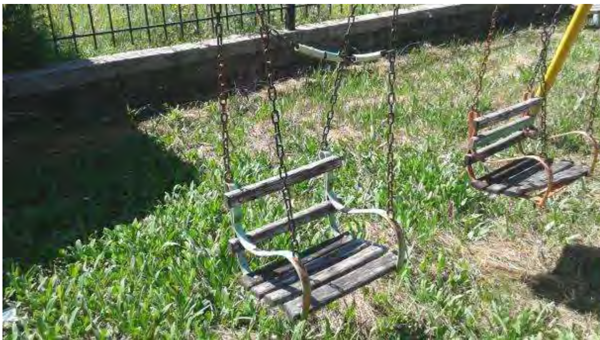
Εικόνα 16: Ακατάλληλα καθίσματα και αλυσίδες στην κούνια Νο2.
