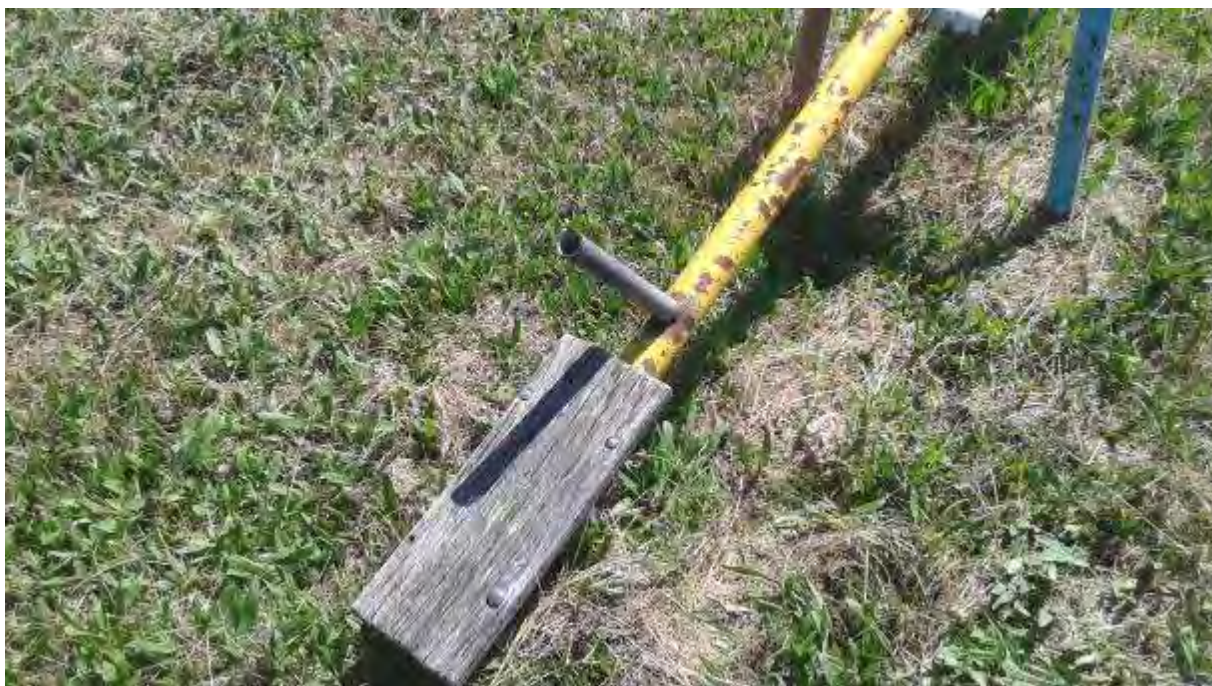
Εικόνα 12: Θέση χρήστη στην τραμπάλα. Διακρίνονται η έλλειψη χειρολαβής, η φθορά της ξυλείας του καθίσματος καθώς και η οξείδωση του άξονα του οργάνου.
