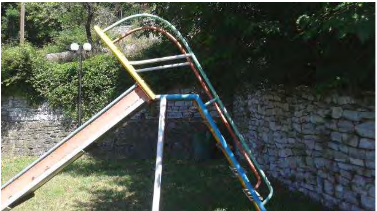
Εικόνα 18: Ανεπαρκές φράγμα το οποίο διαθέτει οριζόντια στοιχεία στην πλατφόρμα της τσουλήθρας.
