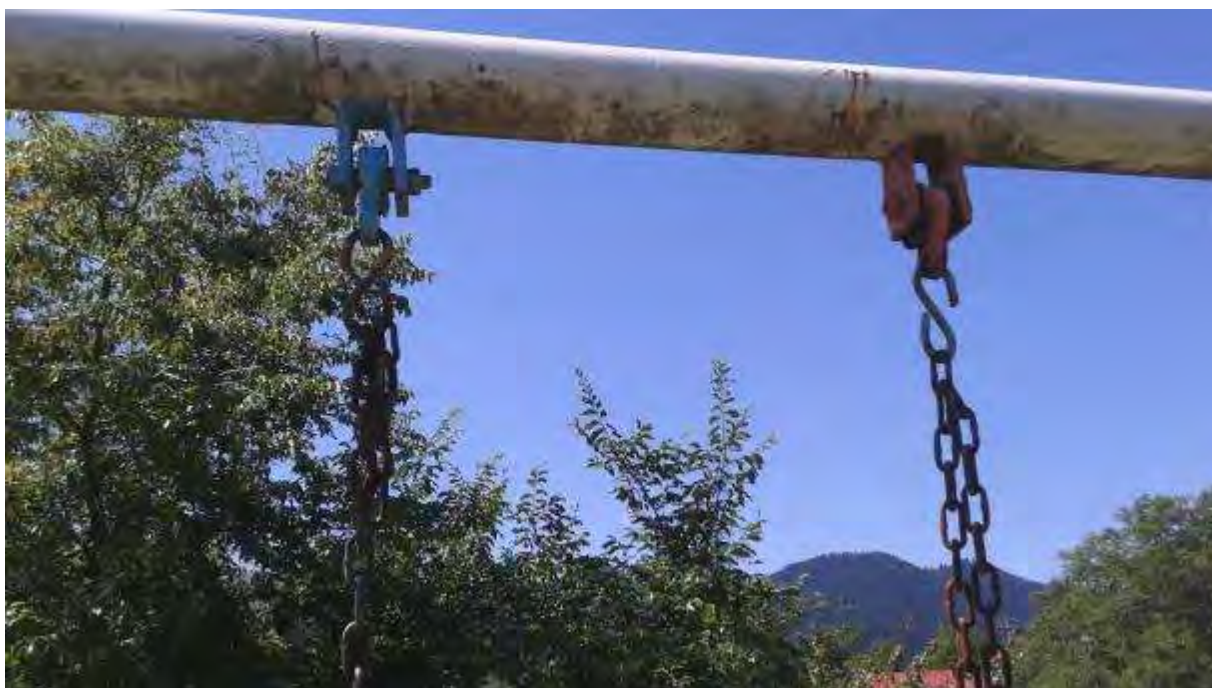
Εικόνα 11: Ακατάλληλος τρόπος ανάρτησης των καθισμάτων της κούνιας Νο1.
