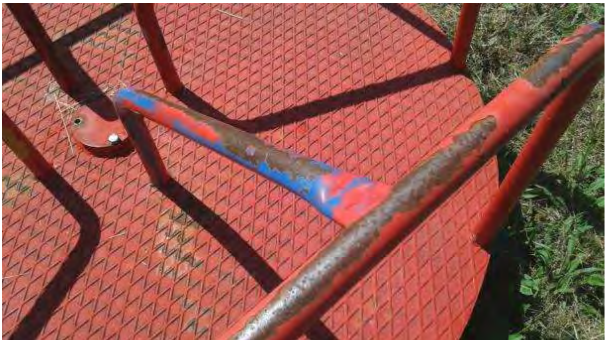
Εικόνα 14: Οξείδωση στον μύλο Νο1.
